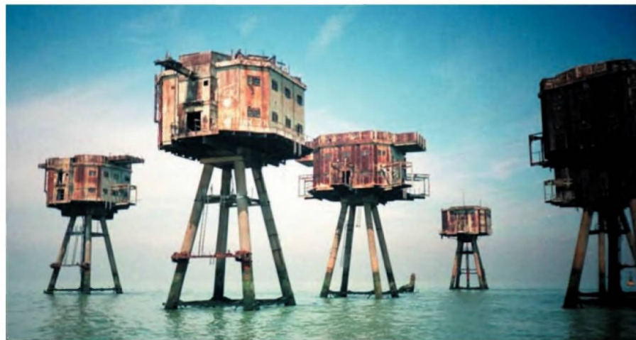
Современное состояние фортов Маунселла. Переходные мостики демонтированы, из воды торчат обломки конструкций
