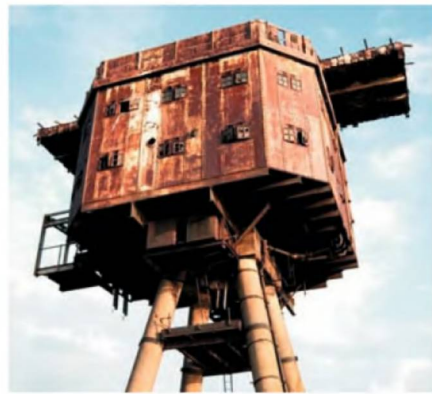
Современное состояние фортов Маунселла. Переходные мостики демонтированы, из воды торчат обломки конструкций
