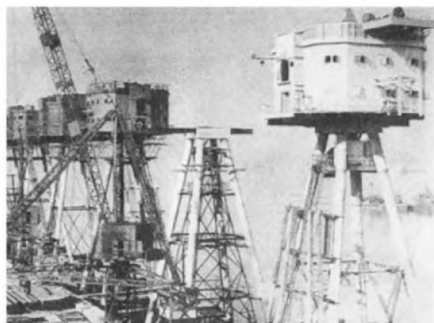
Строительство башен армейских зенитных фортов на британской верфи «Братья Холлоуэй» (Holloway Brothers Ltd.). 1942 г.
