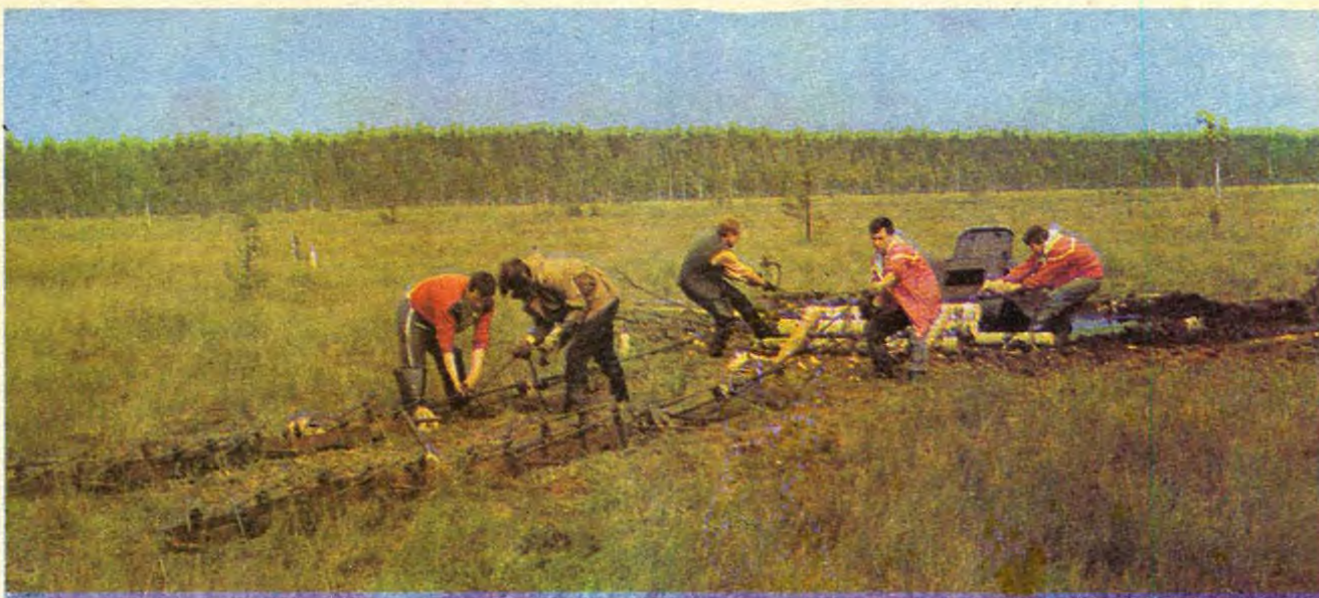
Укладываем деревянный настил, крепим лебедки и якоря.
