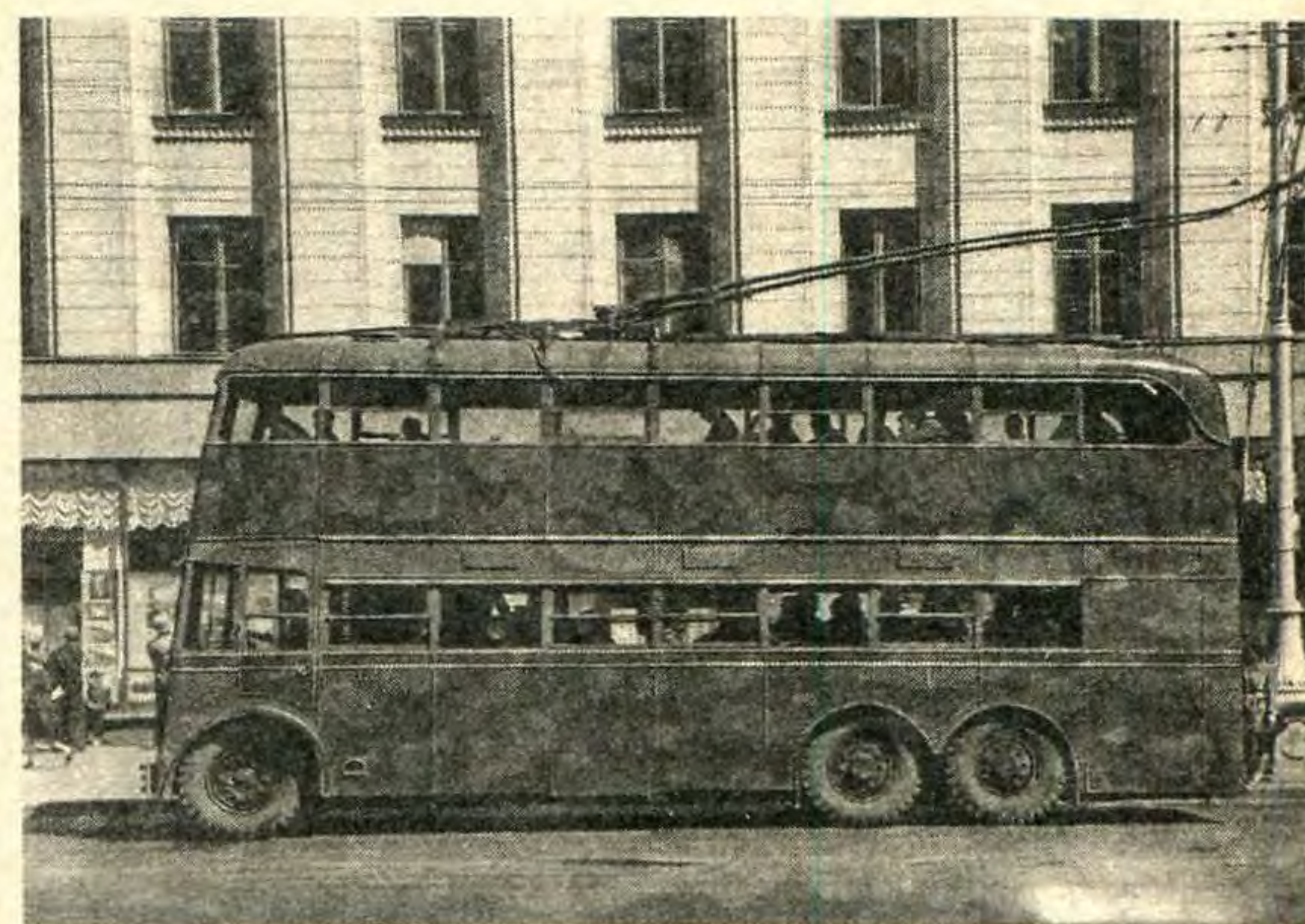
Ярославский «двухэтажник» ЯТБ-3, 1938 год (длина — 9,5 м, ширина — 2,5 м, места — 38 сверху и 34 внизу, высота — 5 м).
