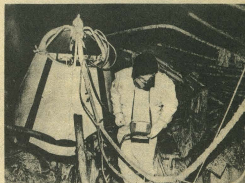
В реакторный зал разрушенного блока удалось проникнуть человеку. И не просто проникнуть, а взобраться на самое опасное место — на «Елену». Так называют здесь металлоконструкцию крышки реактора — схемы «Е», которая при взрыве встала почти вертикально, вырвав при этом из аппарата сотни технологических труб.
