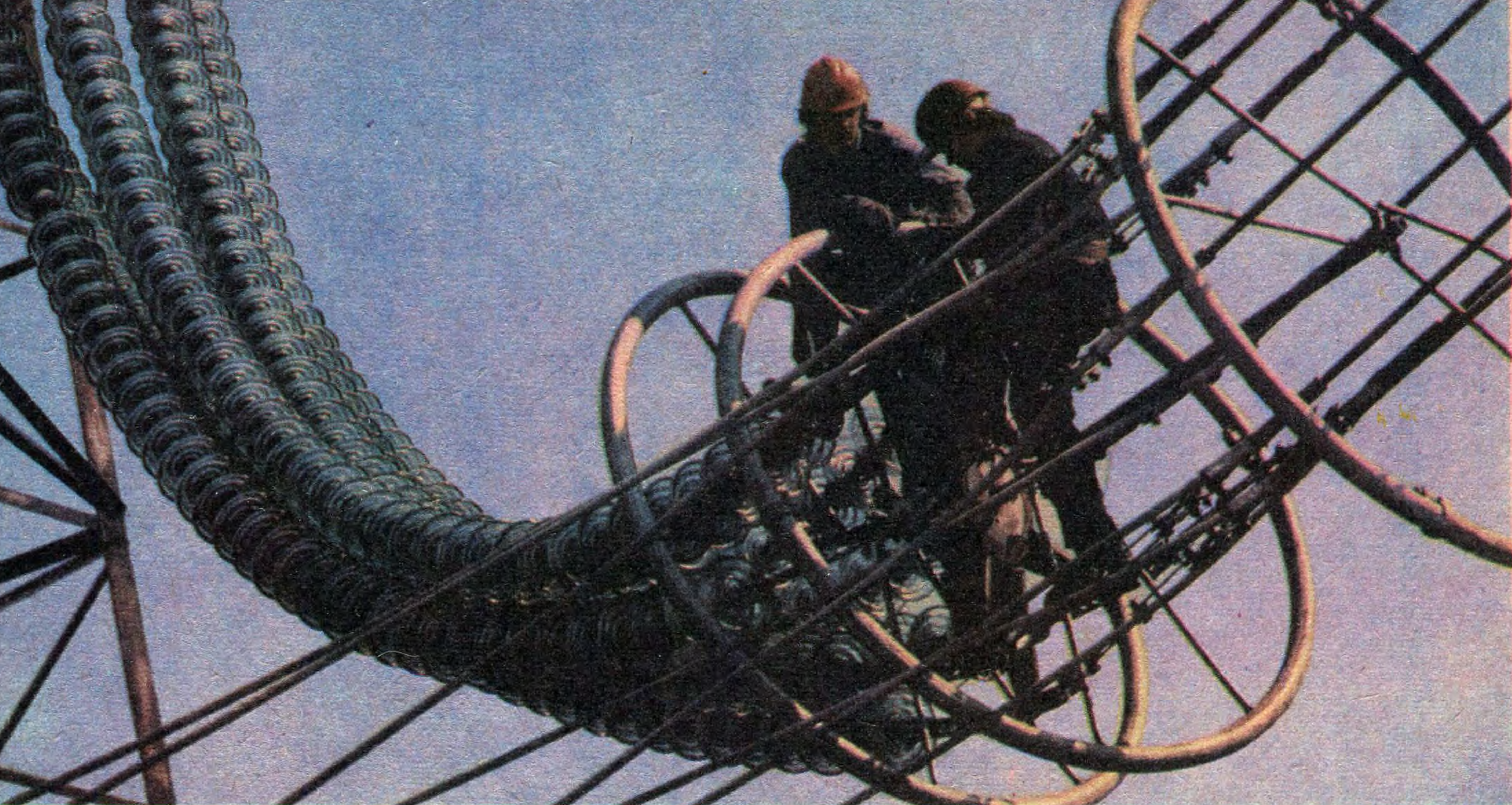
Монтаж линии ультравысокого напряжения.
