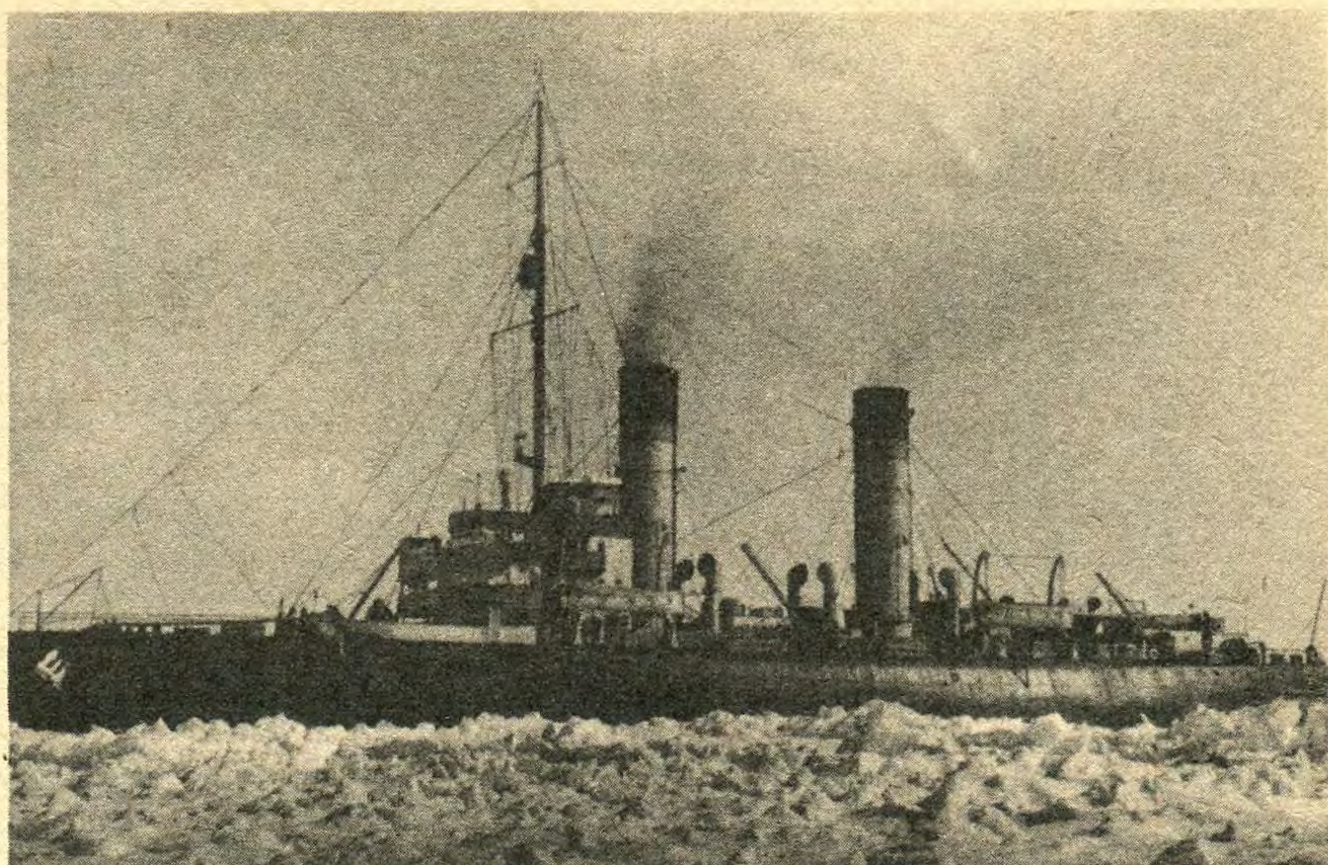
Орден Ленина ледокол «Ермак» во льдах. Построен в 1899 году, водоизмещение — 8790 т, мощность паровых машин — до 10 тыс. л. с.
