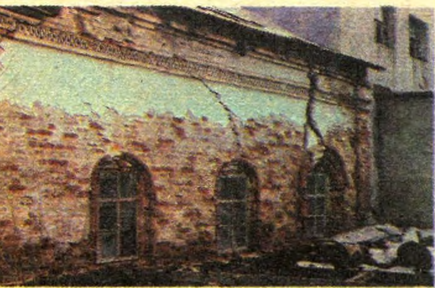
Осадка фундамента под зданием привела к его деформации, в результате чего появились трещины.
