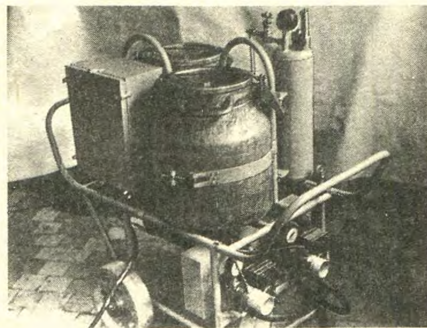
Установка «Пена-9м» для герметизации кузовов автомобилей сконструирована специалистами Всесоюзного научно-исследовательского института синтетических смол.
