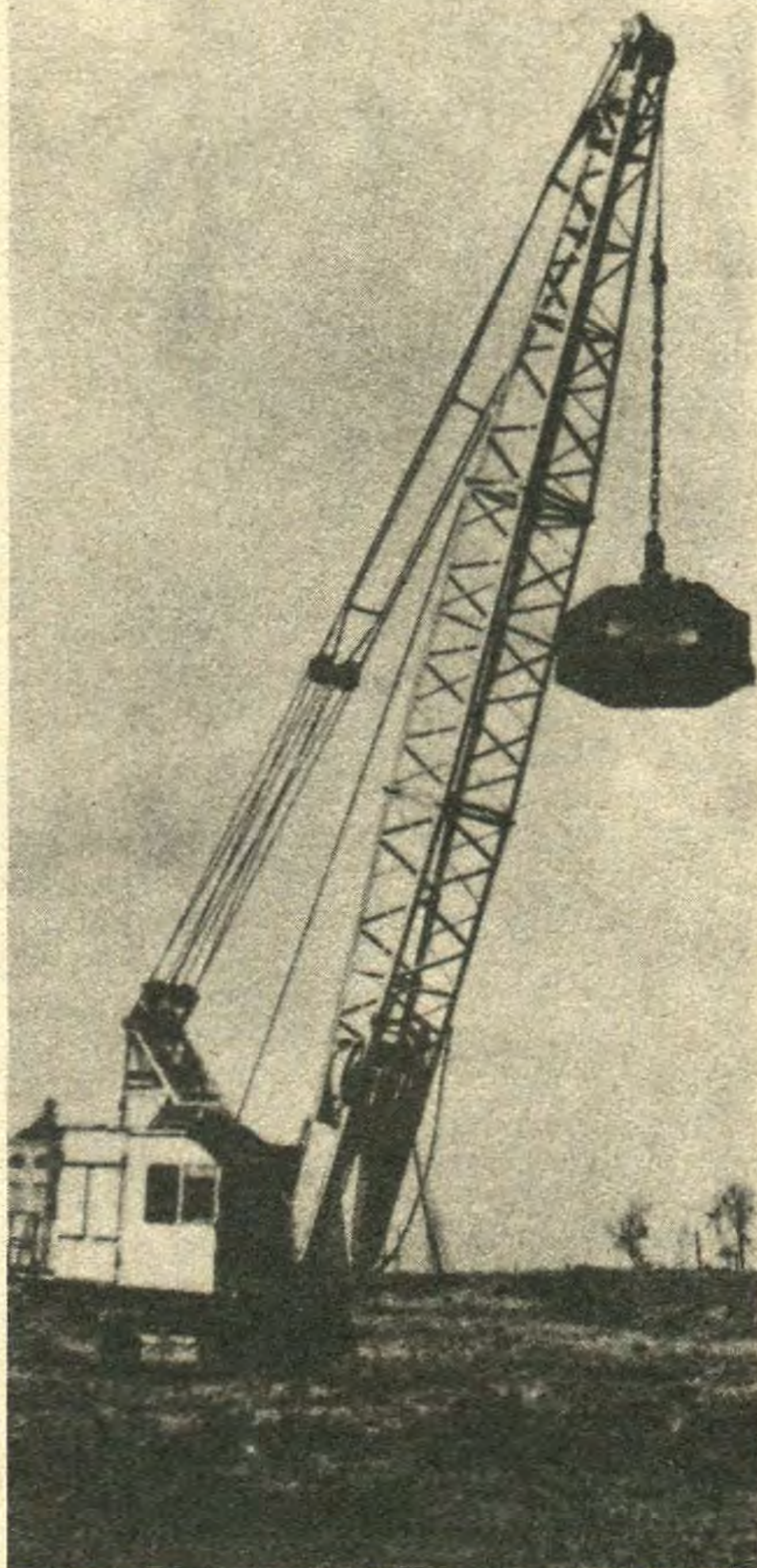
Удар, еще удар! Так уплотняется грунт.
