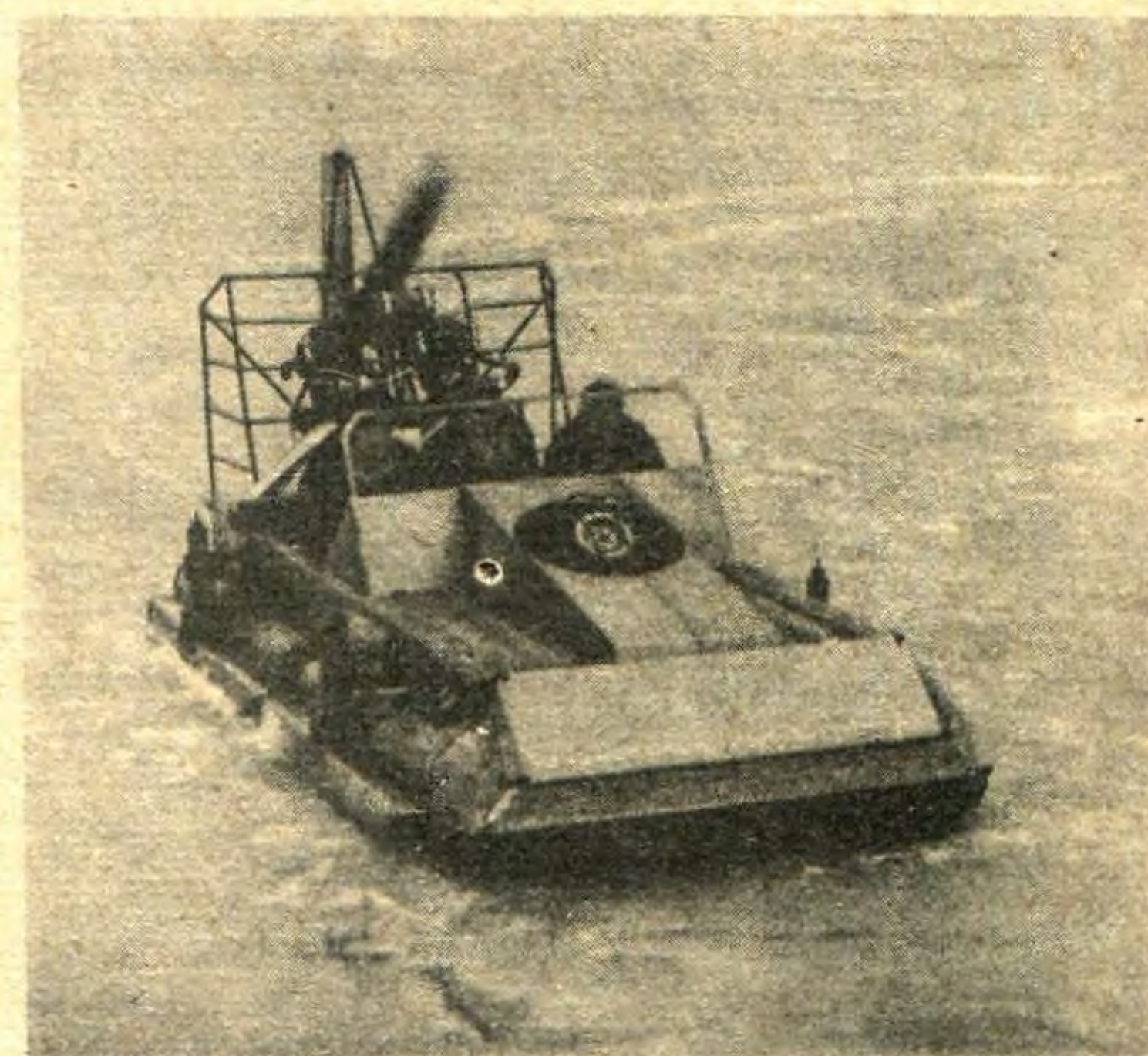
Снегоход-амфибия с воздушной разгрузкой САВР-1 (САВР-13) способен транспортировать по бездорожью и рекам трех человек и 500 кг груза в любое время года. Ориентировочная стоимость этой машины при серийном выпуске около 2 тыс. руб.
