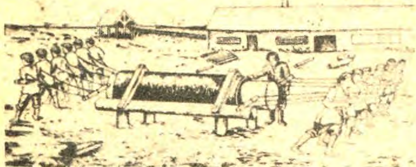
Обработка цилиндра для паровой машины Ньюмена английским мастером Р. РЕЙНОЛЬДСОМ в 1760 г. Одна шестерка рабочих тянет колоду с резцами, другая отдыхает.
