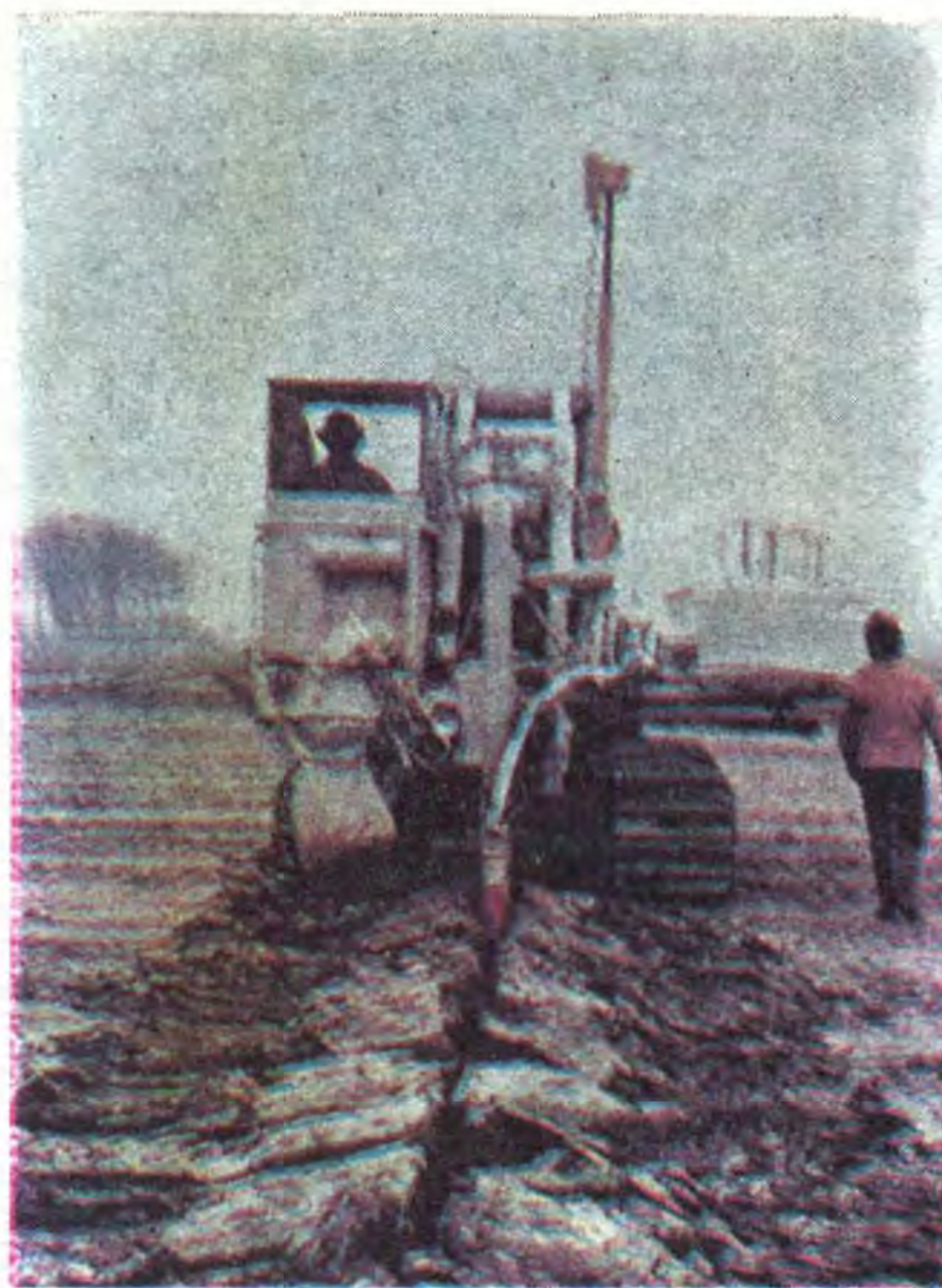
Таким образом дренажная труба, обернутая нетканым материалом БИДИМ, укладывается в траншею.
