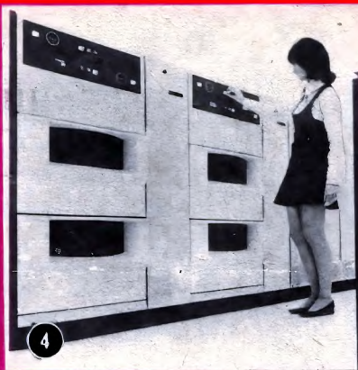
Некоторые элементы системы подготовки рукописи: 3 — процессор, 4 — ЭВМ, 5 — быстропечатающее устройство, 8 — дисплей, 10 — фотонаборный автомат.
