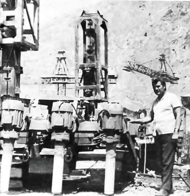
Начальник управления «Андижангидрострой» Виктор Медведев демонстрирует вибропакет, которым уплотняют и выравнивают бетон.
