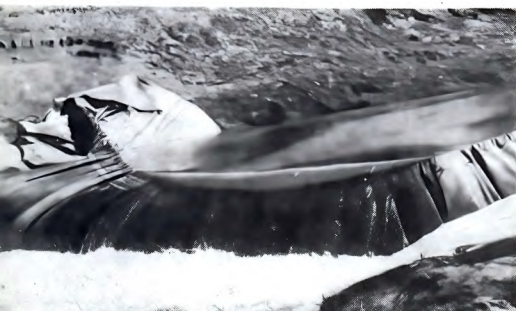
Мембранная плотина на реке Меше в Татарской АССР. Длина 16 м, высота 2 м. Водоем, образованный ею, используется для орошения 60 га пастбищ. Такая конструкция применяется при небольших пролетах.
