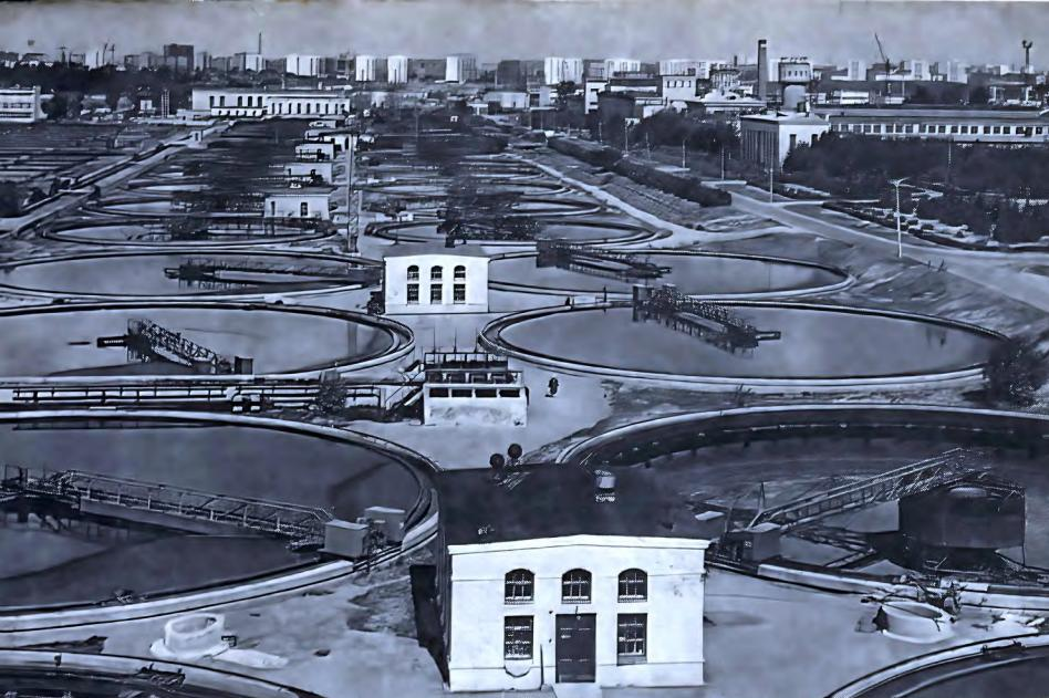
**О**бъединение Курьяновских станций аэрации — крупнейшее в мире предприятие по очистке сточных вод. Оно оснащено комплексом новейших сооружений и уникальным оборудованием, позволяющим задерживать до 96% вредных веществ. Осадок здесь подсушивается, после чего используется как ценные органические удобрения. Мощность станции доведена до 2 млн. куб. м в сутки, а в конце пятилетки она увеличится до 3 млн. Применение новых методов очистки позволит использовать сточные воды для промышленных нужд.
