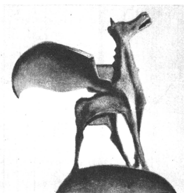
Рис. 1. Скульптура «Пегас» — это первая художественная отливка, полученная методом газификации.
