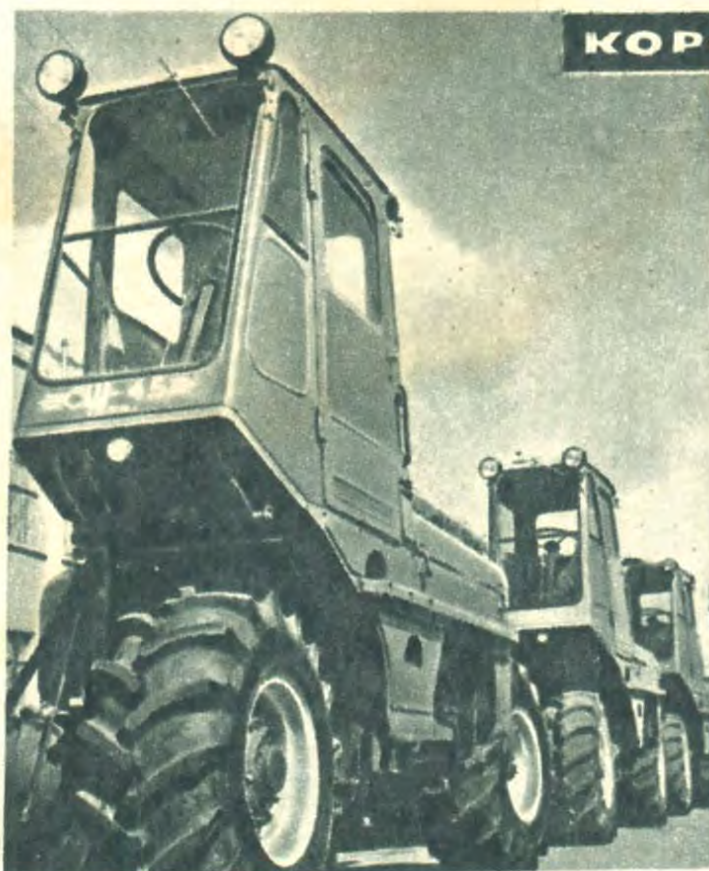
Самоеходные шасси «СШ-45», предназначенные для районов северных и северо-западных областей с повышенной влажностью почвы.
