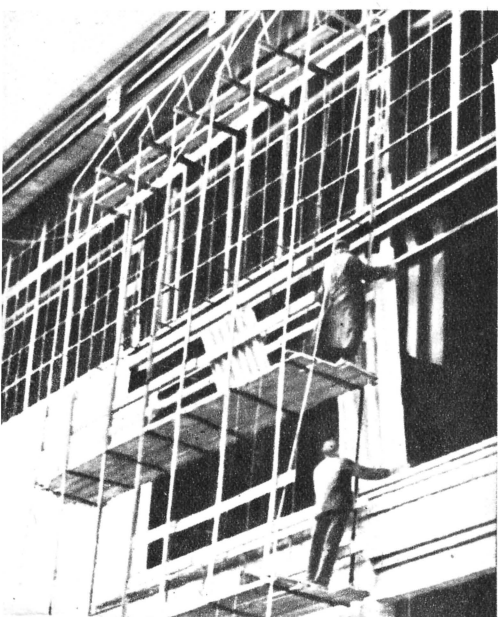
Волнистые асбесто-цементные плиты и один из способов крепления их на месте монтажа. Пружинный зажим делается для температурной компенсации.
