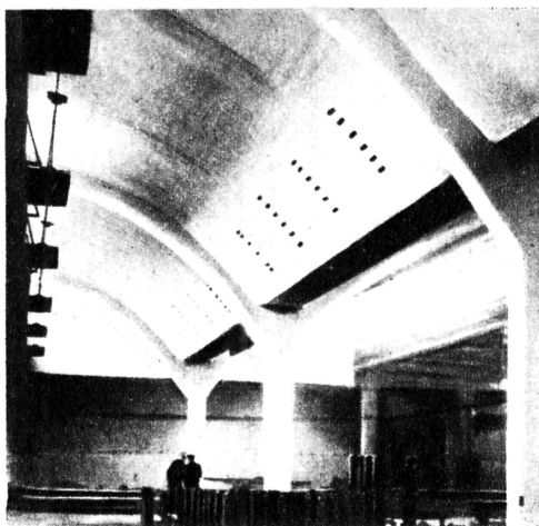
Внутренний вид производственного помещения, перекрытого кривым тонкостенным сводом.
