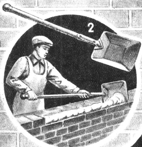
2. Ковш-лопата Мальцева, значительно повышающий производительность труда. 3. Одно из новаторских начинаний П. С. Орлова — упорядочение и организация рабочего места.
