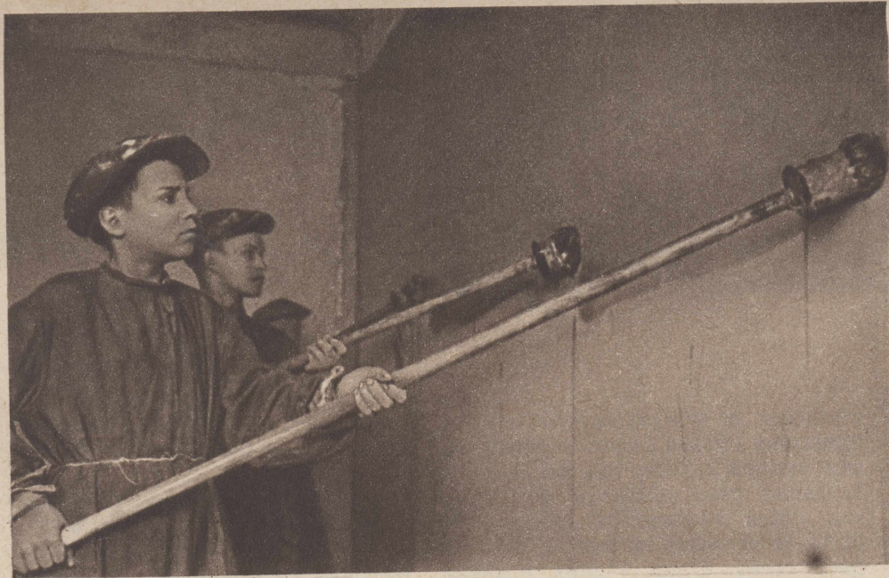
Стена промывается раствором купороса. После такой подготовки краска на нее ложится прочно и ровно.
