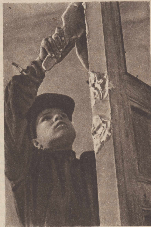
Прежде чем красить стены или двери, надо заделать все трещины и неровности особой замазкой — шпаклевкой.
