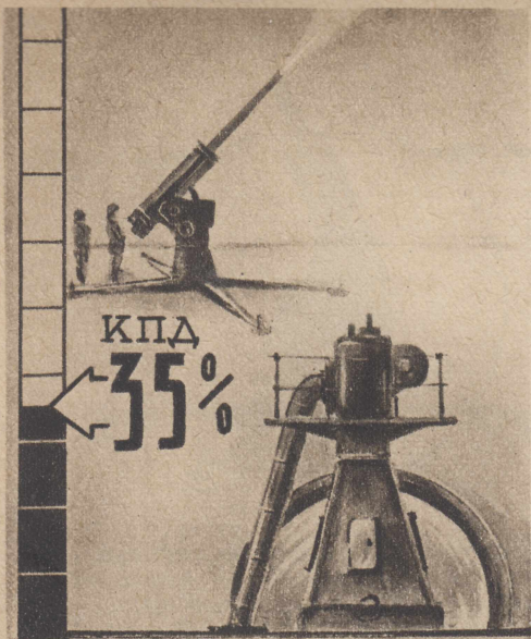
Артиллерийское орудие и дизельмотор обладают одинаковым коэффициентом полезного действия.
