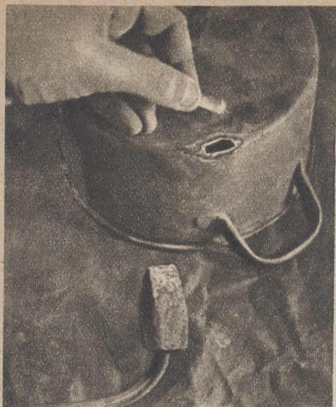
Большая дыра заделывается с помощью заплатки, вырезанной из жести.
