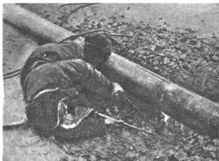
С помощью газовой сварки соединяются отдельные куски стального трубопровода.
