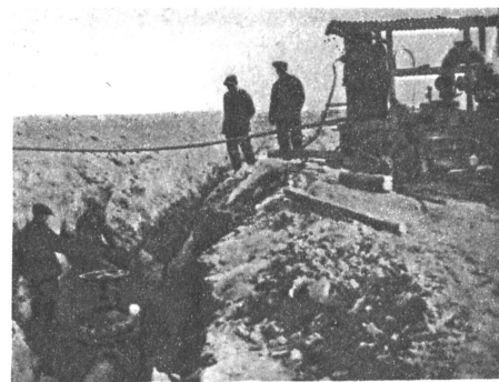
В уложенный трубопровод для испытания его прочности нагнетается вода под давлением в 75 атмосфер.
