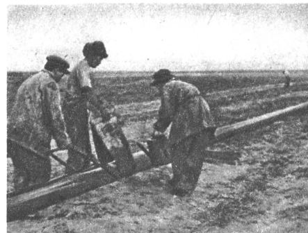
Очищенная от грязи и ржавчины, труба покрывается слоем битума и обертывается защитной прокладкой.
