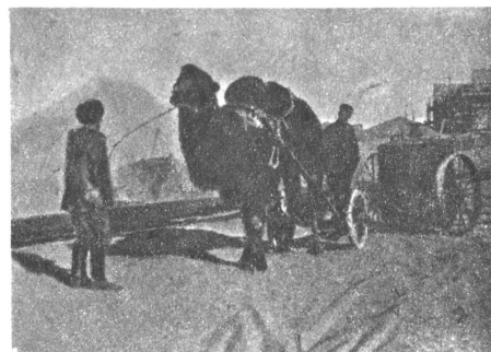
В таких походных чанах разогревается битум (расплавленная смола) для изоляции труб.
