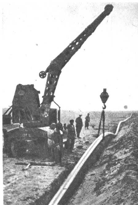
Защищенная от коррозии нитка стальной трубы опускается в траншею с помощью передвижного автокрана.
