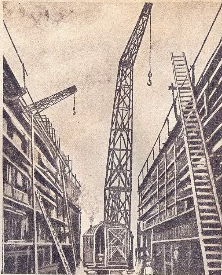
Монтаж железного каркаса многоэтажного здания с помощью строительного крана.
