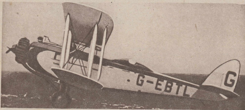
Современный скоростной одноместный самолет. Обращают на себя внимание небольшие размеры плоскостей и хвостового оперения. «Зализанность» самолета доведена до пределов. Такой самолет достигает скорости 550 км в час.
