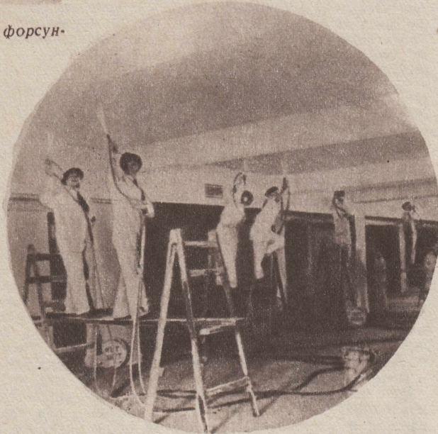
Окраска помещения с помощью аэрографов.
