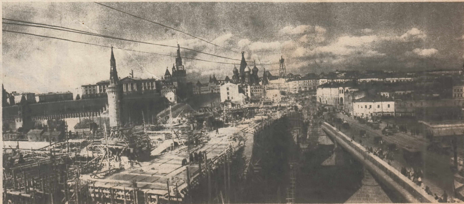
Панорама строительства Москворецкого моста. Справа — старый Москворецкий мост, построенный в 1871 г. Новый мост открыт 7 ноября 1937 г. В отличие от других новых мостов на Москва-реке он построен из железобетона.
