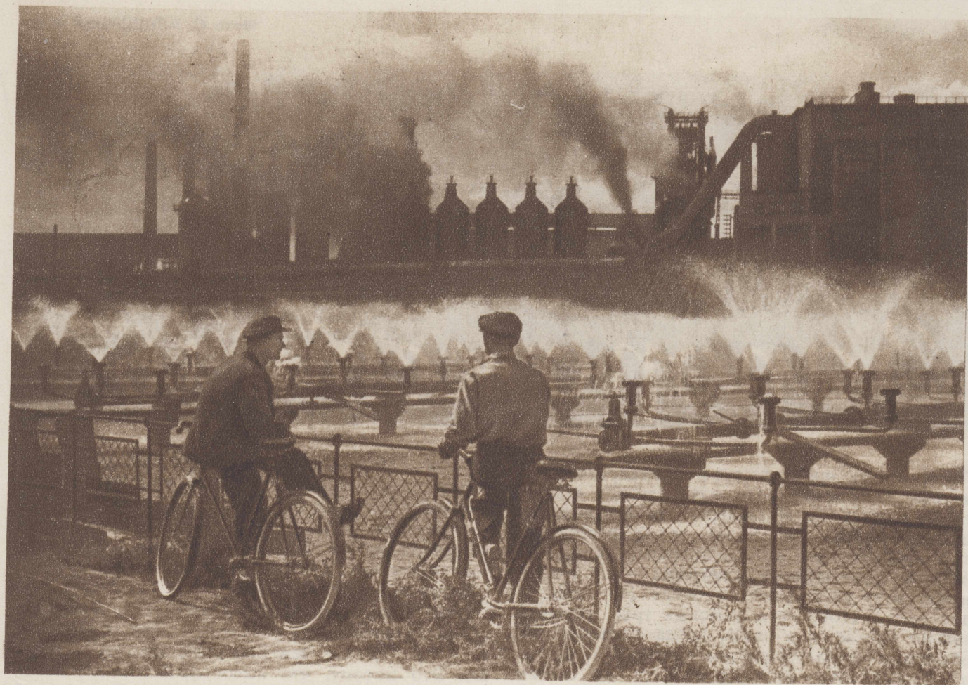
Для охлаждения стен доменных печей Запорожстали уходит огромное количество воды — до 20 миллионов литров в сутки. Чтобы не выливать нагретую воду в реку, ее пропускают через так называемые брызгала. Распыленная вода теряет свое тепло и снова идет на охлаждение печей.
