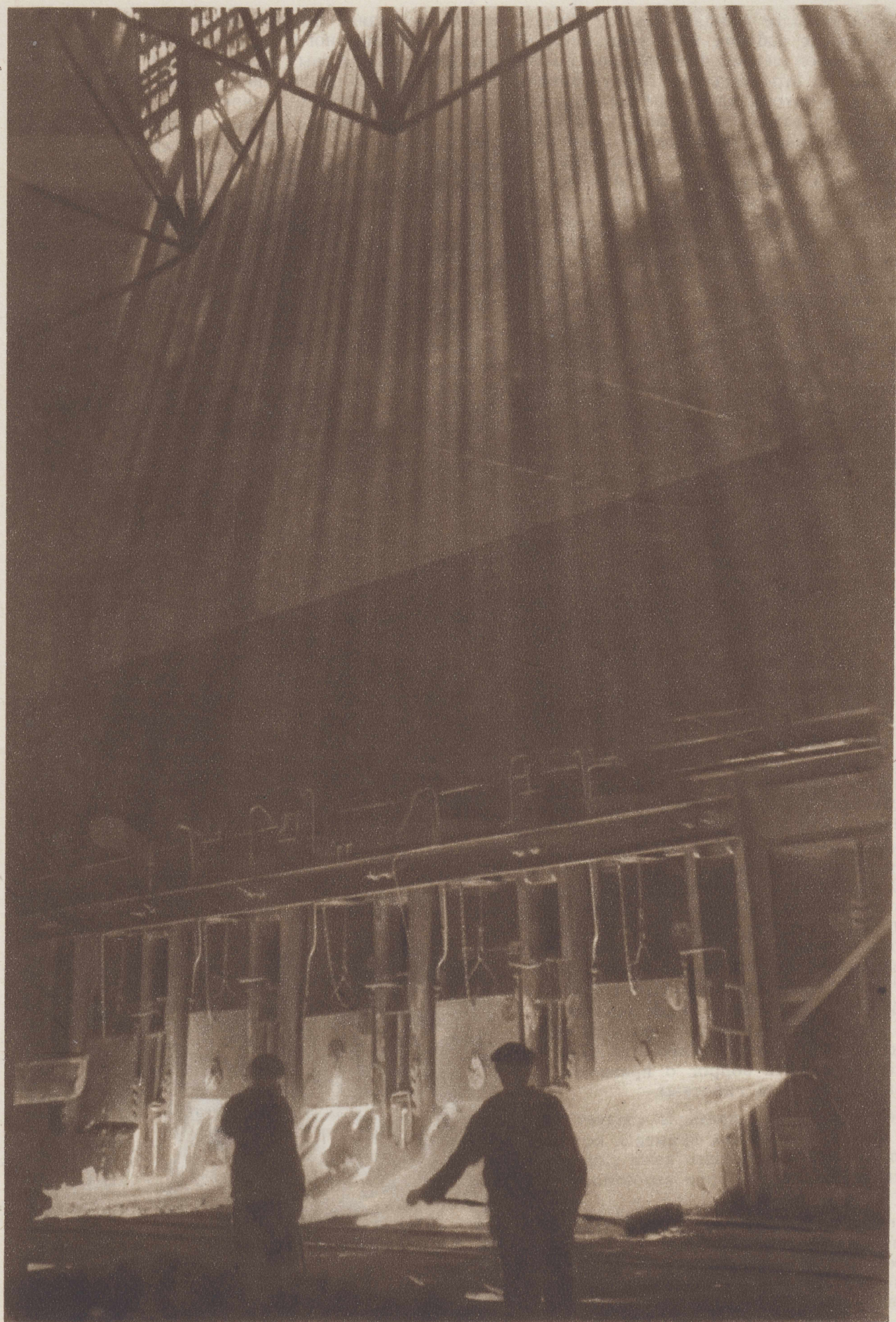
Вы видите мартеновскую печь со стороны загрузочных окон. Образовавшийся в печи шлак начал переливаться через пороги и заливать рабочую площадку. Чтобы приостановить вытекание шлака, сталевары забрасывают на порог доломит.
